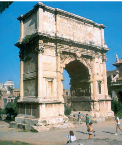
Восточный фасад Арки Тита
